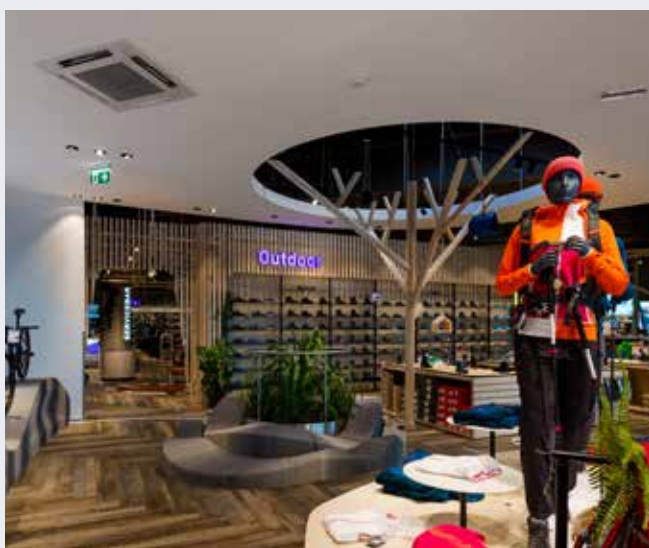
Trgovački centar PADO Shopping Galerien Pamdorf, tvrtka CAVERION Österreich GmbH Klimaanlage und Wärmepumpen
